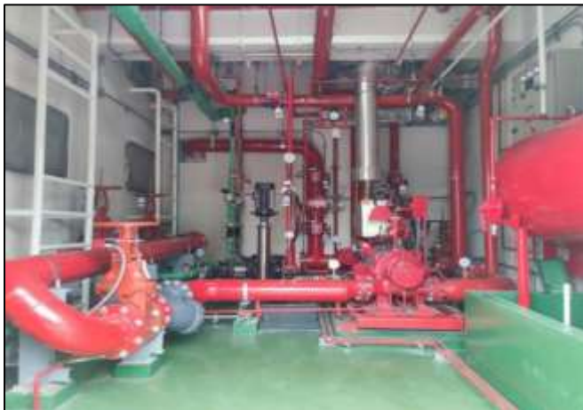
รูปที่ 2-29 ถังสำรองน้ำ และปั้มน้ำดับเพลิง
