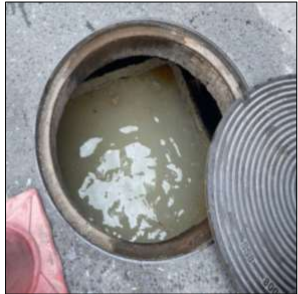
รูปที่ 2-27 การตัดไขมันจากบ่อดักไขมัน
